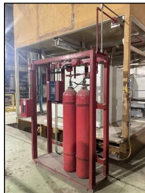
รูปที่ 2-24 ถังดับเพลิงประเภท \text{CO}_2
