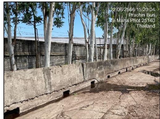
รูปที่ 2-8 คันคอนกรีตรอบบริเวณลาน Bio Fuel
