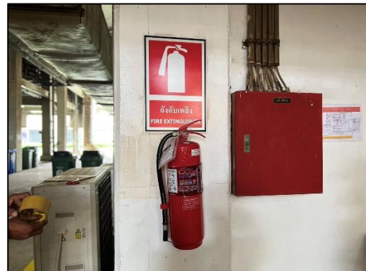
รูปที่ 2-23 ถังดับเพลิงประเภทผงเคมีแห้ง
