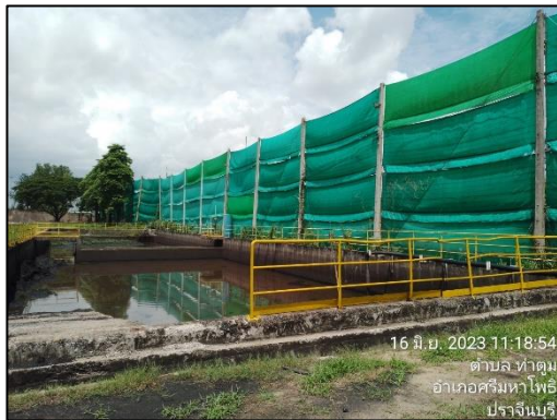
รูปที่ 2-11 บ่อดักตะกอน และบ่อดักไขมัน บริเวณปลายรางระบายน้ำทิ้ง
