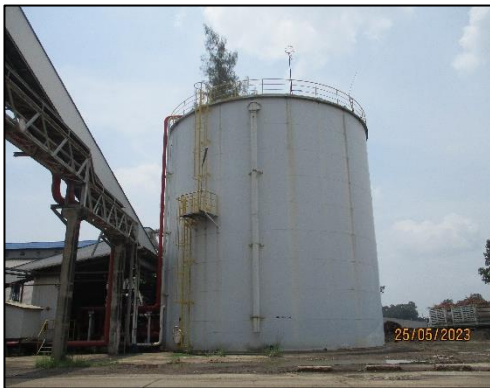
รูปที่ 2-22 ถังเก็บน้ำสำรองดับเพลิง ขนาด 4,000 \text{m}^3
