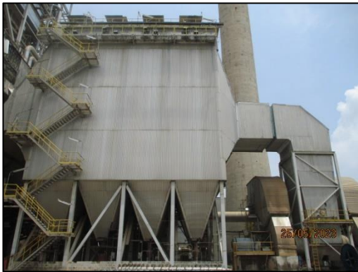
รูปที่ 2-1 ระบบดักฝุ่นแบบไฟฟ้าสถิต (ESP)
